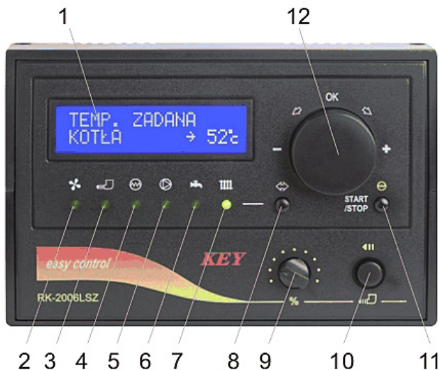
Abbildung 1. Frontplatte vom Regler RK-2006LSZ
